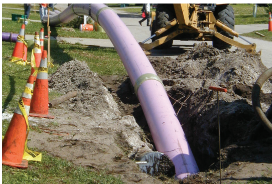
Installation d'une conduite Certa-Lok/RJ par FDH qui démontre la capacité de courbure d'un tronçon de conduite Certa-Lok sans compromettre l'intégrité du joint à garniture.
